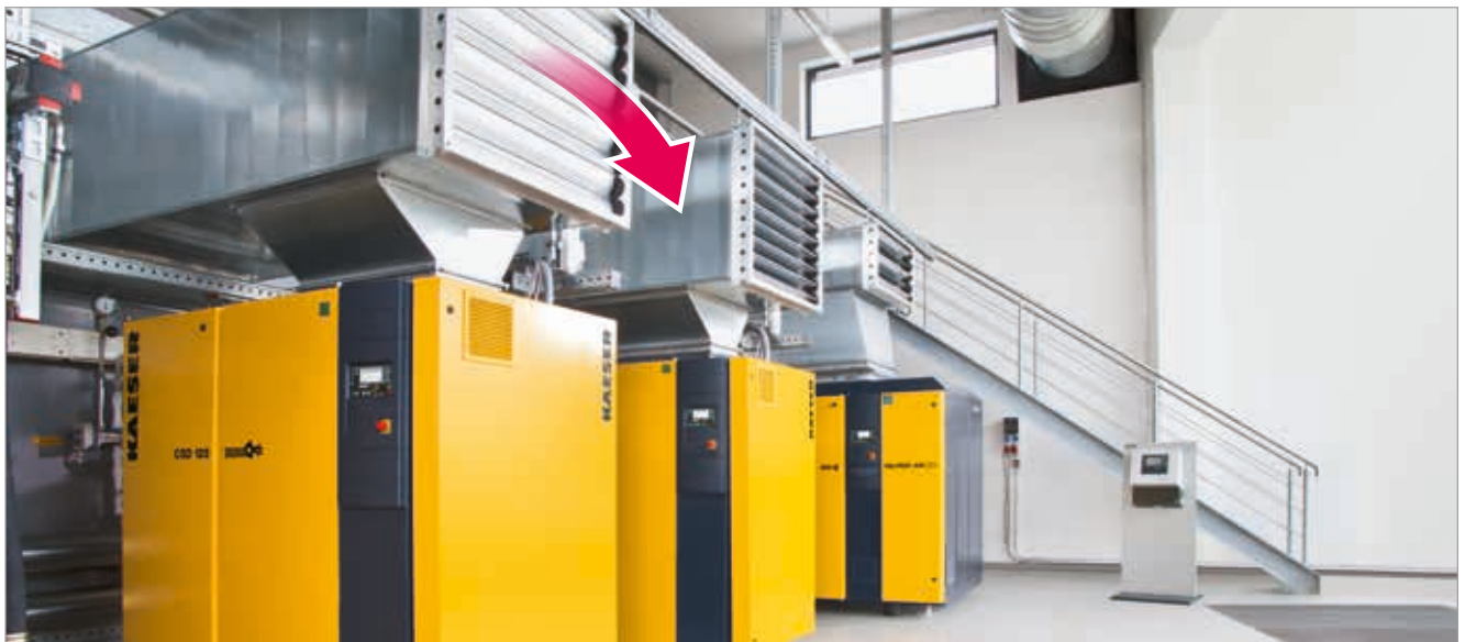
איור 3: תחנת אוויר דחוס עם בקרת טמפרטורה על האוורור
