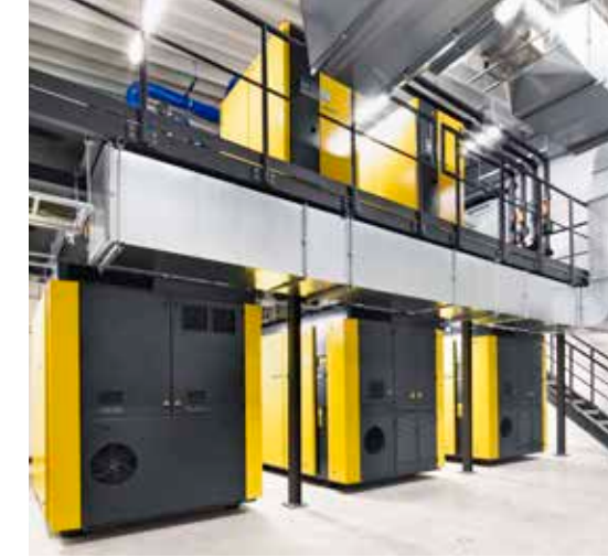
תמונה מימין: כאן מייצרים רצועות ענק של סרט פלסטיק. תמונה משמאל: תחנת האוויר הדחוס מותקנת על פני שני מפלסים כדי לחסוך במקום.
